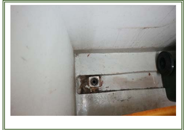
รูปที่ 2-26 ท่อรวบรวมน้ำเสียจากห้องพักมูลฝอย
