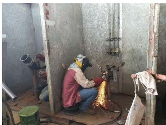
รูปที่ 2-39 ผู้ปฏิบัติงานสวมใส่อุปกรณ์คุ้มครองความปลอดภัยส่วนบุคคลสำหรับงานเชื่อม
