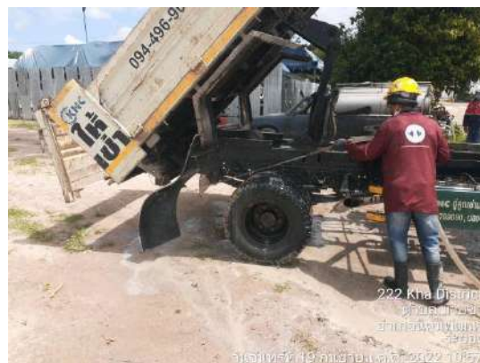
รูปที่ 2-5 การล้างล้อก่อนออกจากพื้นที่โครงการ
