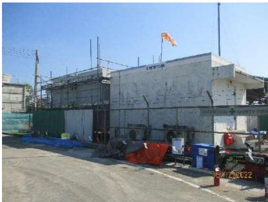
รูปที่ 2-20 การกั้นแบ่งเขตพื้นที่วางเครื่องจักร และการจัดเตรียมพื้นที่สำหรับวางอุปกรณ์เครื่องมือต่างๆ
