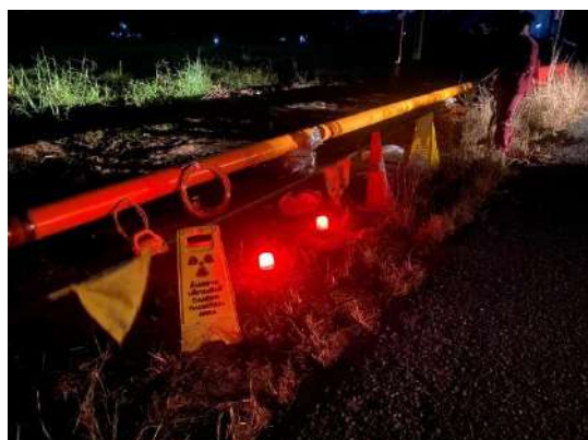
รูปที่ 2-28 ไฟสัญญาณกระพริบและ ไฟแสงสว่างเตือน
