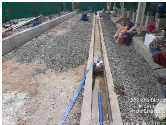
รูปที่ 2-31 การติดตั้งแผ่นกรองที่รางระบายน้ำ และการทำความสะอาดรางระบายน้ำ
