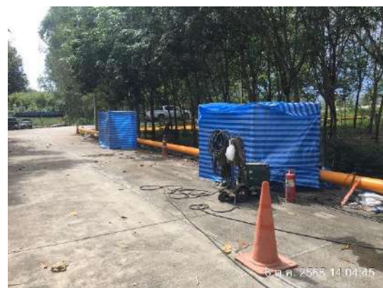
รูปที่ 2-40 การกั้นเขตบริเวณพื้นที่ที่มีการเชื่อมต่อ
