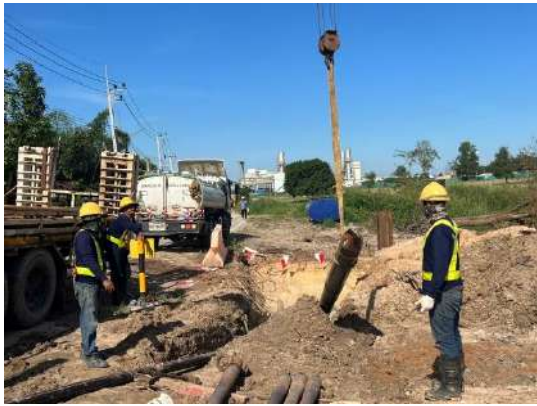
รูปที่ 2-18 การสังเกตและเผื่อแรงดัน/ปริมาณ/ ความต่อเนื่องของอัตราการไหลของโซเดียมเบนโทไนท์ที่ ส่งกลับมา (Mud Return Line)
