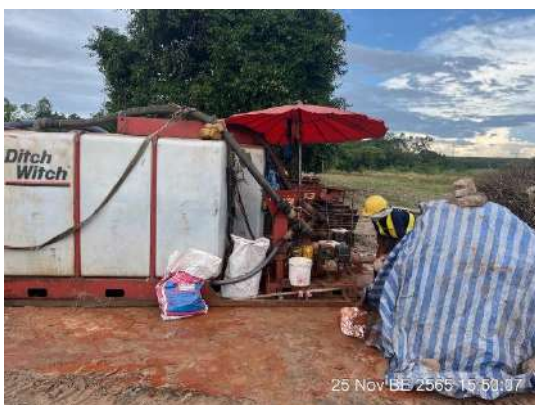
รูปที่ 2-34 การผสมโซเดียมเบนโทไนท์เพื่อใช้ในการ เจาะลุด
