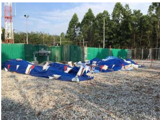
รูปที่ 2-4 การปิดคลุมหน้าดินป้องกันการฟุ้งกระจายของฝุ่นละออง
