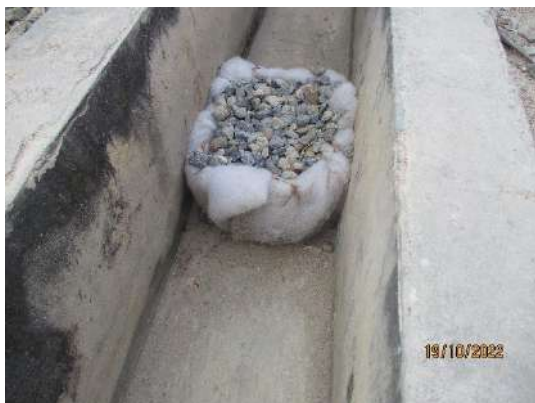
รูปที่ 2-31 การติดตั้งแผ่นกรองที่รางระบายน้ำ และการทำความสะอาดรางระบายน้ำ
