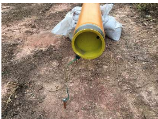
รูปที่ 2-45 ตั้ง Ground rod
