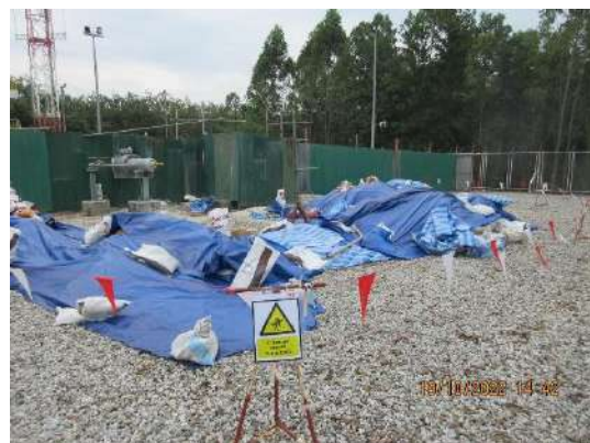
รูปที่ 2-4 การปิดคลุมหน้าดินป้องกันการฟุ้งกระจายของฝุ่นละออง
