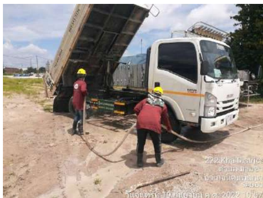
รูปที่ 2-5 การล้างล้อก่อนออกจากพื้นที่โครงการ
