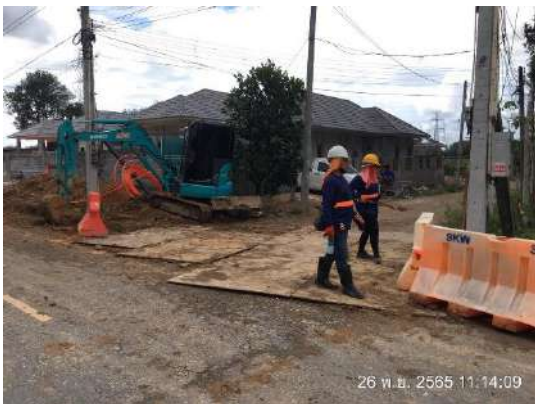
รูปที่ 2-24 ภาพการวางแผ่นเหล็ก
