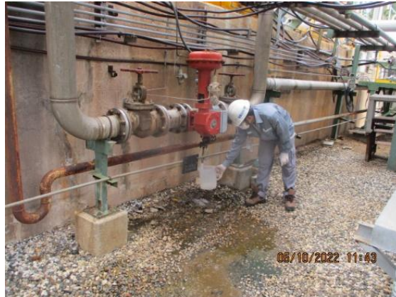
จุดระบายน้ำเข้าระบบบำบัดน้ำเสีย (Receiving Tank) ก่อนเข้า Equalization Cooler
