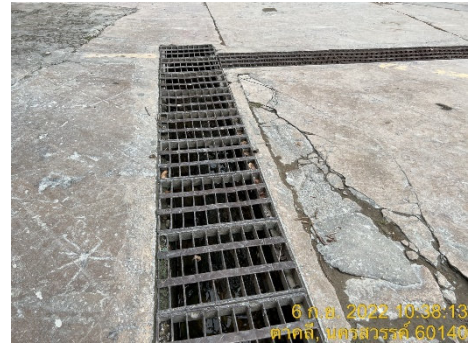
รูปที่ 39 รางระบายน้ำหลักของโครงการ
