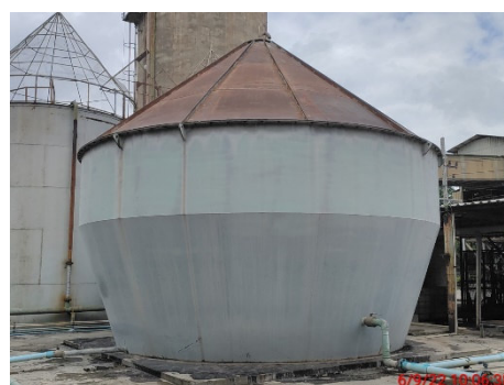
รูปที่ 28 ถังตกตะกอนของระบบประปา
