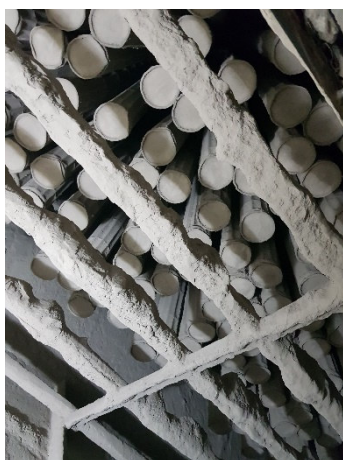
รูปที่ 56 การทำความสะอาดและตรวจสอบถุงกรอง
