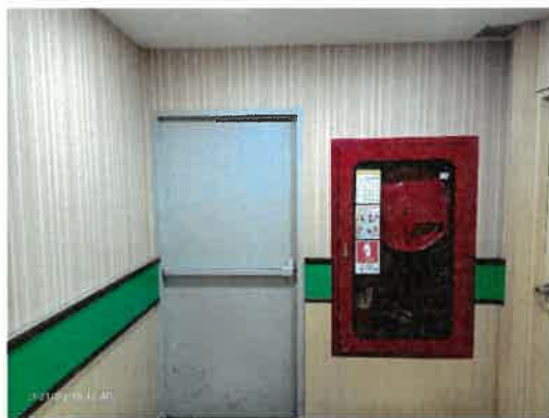
ตู้ FHC (มีสายยางดับเพลิง และถังเคมีดับเพลิง) และป้ายแสดงวิธีการใช้อุปกรณ์ดับเพลิง
