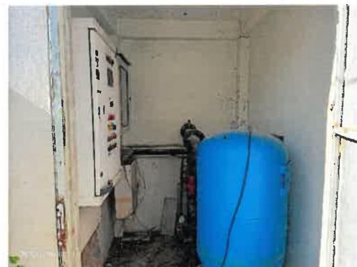
ตู้ควบคุมการสูบน้ำในบ่อหน่วยน้ำฝน
