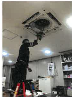
ภาพที่ 2-15 เจ้าหน้าที่ล้างทำความสะอาดเครื่องปรับอากาศ
