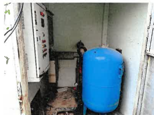
ตู้ควบคุมการสูบน้ำในบ่อท่อน้ำฝน (ไม่ได้ใช้งาน)
