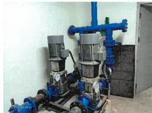
ปั๊มสูบน้ำขึ้นไปยังถังเก็บน้ำดาดฟ้า
