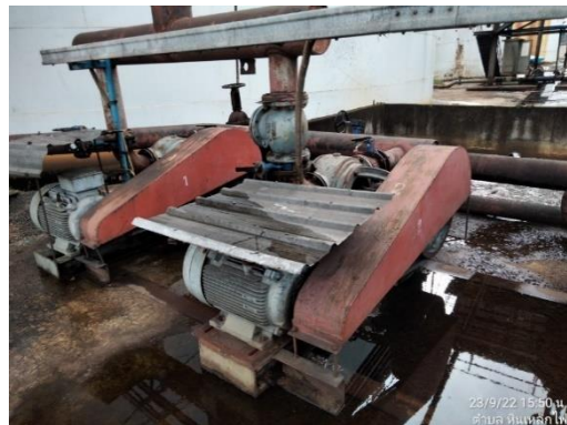
รูปที่ 95 การ์ดป้องกันอันตรายและปุ่มหยุดฉุกเฉิน
