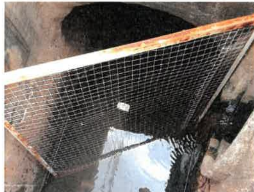
ตะแกรงดักขยะภายในบ่อกักน้ำ
