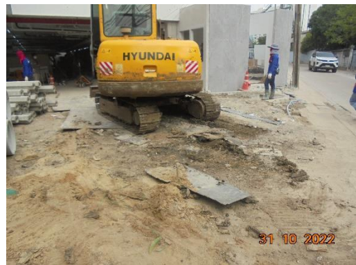
รูปที่ 13 การปูแผ่นเหล็กบริเวณพื้นที่ก่อสร้าง
