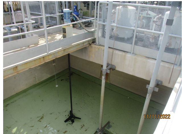
ภาพที่ 2.2-12 บ่อสะเทินสำหรับปรับสภาพน้ำทิ้งปนเปื้อนสารเคมีให้เป็นกลาง
