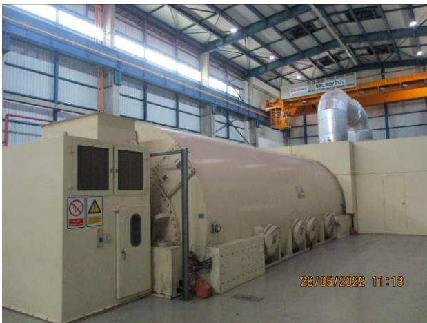
ภาพที่ 2.2-7 อุปกรณ์/อาคารคลุมเครื่องจักรที่มีเสียงดัง
