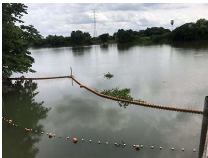
ภาพที่ 2.2-22 ตะแกรงป้องกันสัตว์น้ำและเจ้าหน้าที่ดูแลตลอด 24 ชั่วโมง เพื่อตรวจสอบความผิดปกติก่อนสูบน้ำที่สถานีสูบน้ำโรงไฟฟ้าราชบุรี
