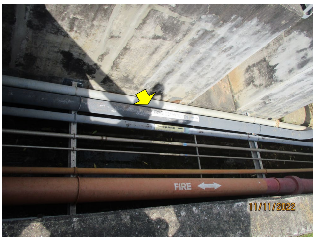
ภาพที่ 2.2-14 การนำน้ำจาก HRSG Blow down และหอต่เย็นที่บำบัดแล้วมายังบ่อน้ำพุ เพื่อการปรับปรุงทัศนียภาพและนำมารดน้ำต้นไม้ภายในบริเวณโรงไฟฟ้า เพื่อลดการทิ้งน้ำออกสู่ภายนอกให้น้อยที่สุด
