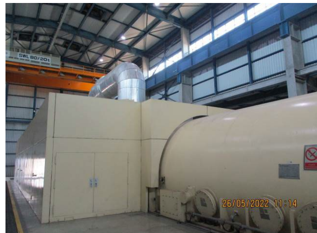
ภาพที่ 2.2-7 อุปกรณ์/อาคารคลุมเครื่องจักรที่มีเสียงดัง
