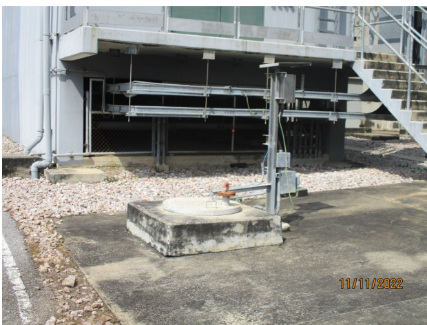
ภาพที่ 2.2-11 Oil Separator สำหรับแยกน้ำมันปนเปื้อนน้ำมัน
