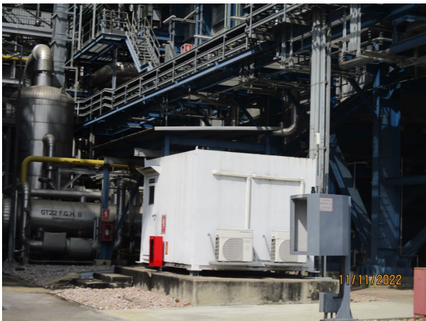
ภาพที่ 2.2-3 ระบบติดตามตรวจสอบการระบายมลพิษอย่างต่อเนื่อง (CEMs)
