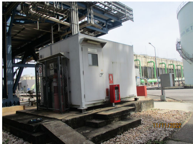
ภาพที่ 2.2-3 ระบบติดตามตรวจสอบการระบายมลพิษอย่างต่อเนื่อง (CEMs)
