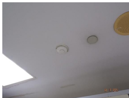
รูปที่ 2-12 ติดตั้งอุปกรณ์จับควัน และตัวจับความร้อน
