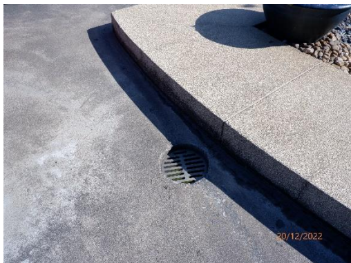
รูปที่ 2-10 ท่อรวบรวมน้ำฝนจากระเบียงชั้น 3 ของอาคารศูนย์ฝึกอบรม
