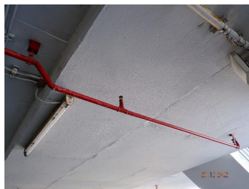
ช) ระบบดับเพลิงอัตโนมัติแบบโปรยน้ำฝอย
