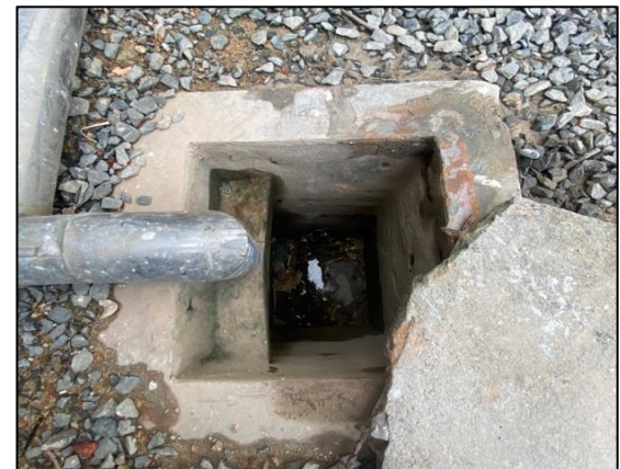
ระบบระบายน้ำฝนจากหลังคาลงสู่บ่อพัก
