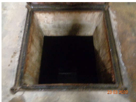
บ่อพักน้ำก่อนผ่านระบบบำบัดน้ำเสีย
