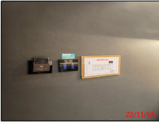
อุปกรณ์ควบคุมการเปิด/ปิดไฟ ภายในห้องพัก
