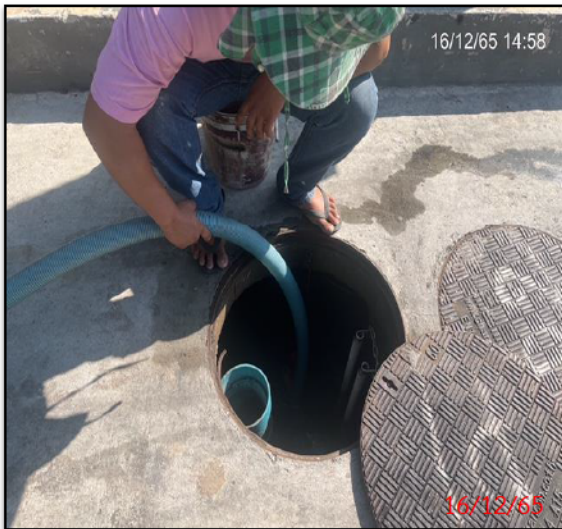
สูบล้างจากบ่อเก็บตะกอนภายในโครงการ
