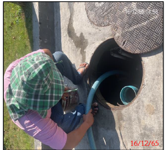
สูบล้างจากบ่อเก็บตะกอนภายในโครงการ
