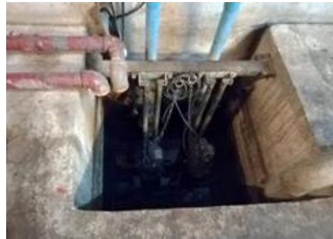
บ่อสูบน้ำขึ้นใต้ดิน
