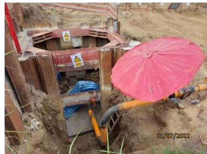
(2) การเตรียมบ่อสำหรับกิจกรรมการเชื่อมต่อส่งก๊าซเดิม (Tie in)
