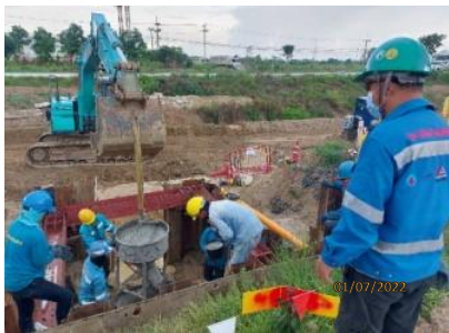
(2) การเตรียมบ่อสำหรับกิจกรรมการเชื่อมต่อส่งก๊าซเดิม (Tie in)
