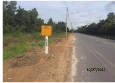
(1) การคืนสภาพพื้นที่ และการติดตั้งเสาป้ายเตือน
