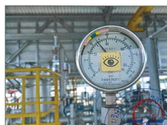
ความดันก๊าซหลังอุปกรณ์รับลดแรงดัน
