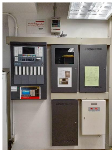
ภาพที่ 2.37 Fire Alarm System
