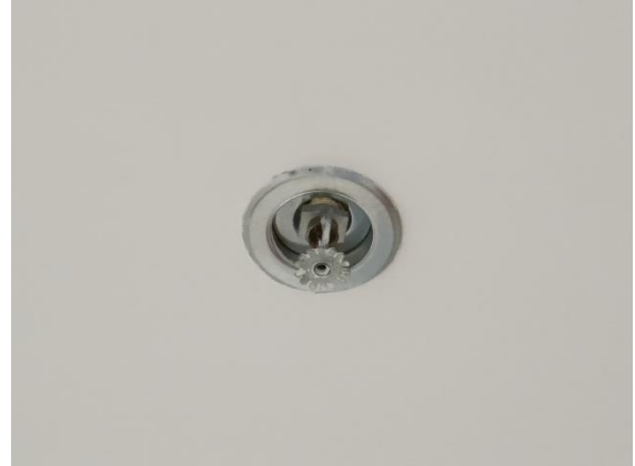
ภาพที่ 2.26 ระบบตรวจจับควัน (Smoke Detector) และระบบดับเพลิงอัตโนมัติ (Sprinkler)
