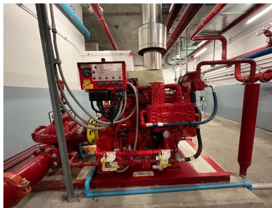
ภาพที่ 2.38 Fire Water Pump
