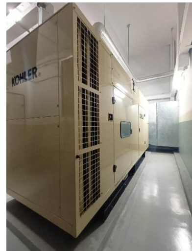
ภาพที่ 2.23 เครื่องกำเนิดไฟฟ้าสำรองฉุกเฉิน (Generator Set)
