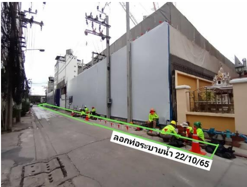
รูปที่ 45 ลอกท่อระบายน้ำ
