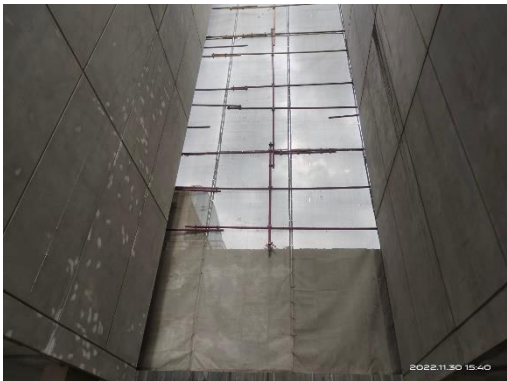
รูปที่ 25 ติดตั้งผ้าใบกันฝุ่น (Mesh Sheet)
