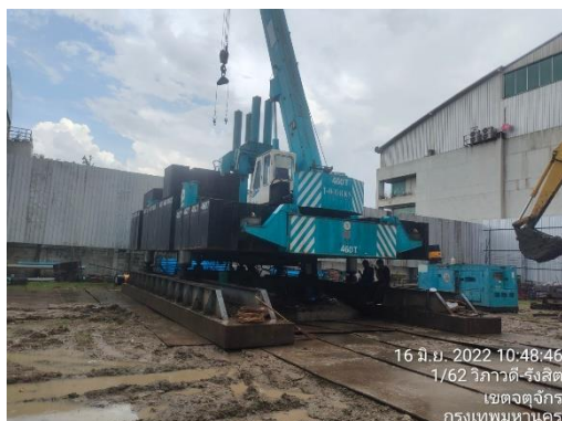
รูปที่ 30 การเจาะเสาเข็มแบบ Jack in Pile
