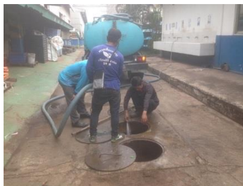
ภาพที่ 12 ทำความสะอาดระบบบำบัดน้ำเสียสำเร็จรูป
