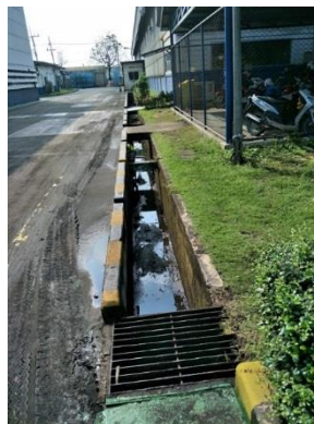
ภาพที่ 10 ท่อรวบรวมน้ำเสียแยกจากรางระบายน้ำฝน
