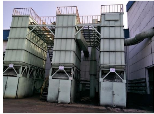
ภาพที่ 2 Bag house (Finishing AMF, Sand AMF, Drum cooling AMF)
