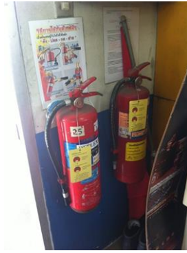
ภาพที่ 24 อุปกรณ์ดับเพลิงแบบมือถือ
