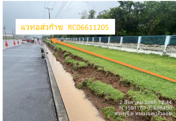
RC6611201 KP.0+254 พบนํ้าฝนไหลกัดเซาะ อยู่ระหว่างติดตามทางนิคม WHA ดำเนินการแก้ไขแล้วเสร็จ
