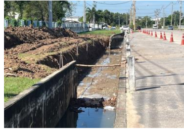
RC6611201 KP.0+254 พบนํ้าฝนไหลกัดเซาะ อยู่ระหว่างติดตามทางนิคม WHA ดำเนินการแก้ไขแล้วเสร็จ
