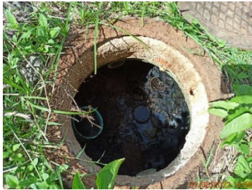
บ่อฟักน้ำหลังผ่านระบบบำบัดน้ำเสียสำเร็จรูปของอาคารหอบังคับการบิน
