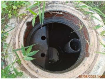
บ่อฟักน้ำหลังผ่านระบบบำบัดน้ำเสียสำเร็จรูปของอาคารผู้โดยสารขาออก
