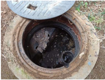
บ่อบำบัดน้ำทิ้งผ่านระบบบำบัดน้ำเสียสำเร็จรูปของอาคารผู้โดยสารขาออก
