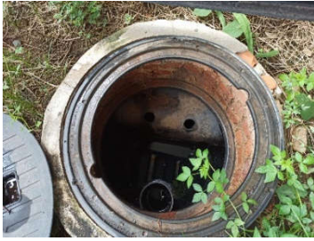
บ่อบำบัดน้ำทิ้งผ่านระบบบำบัดน้ำเสียสำเร็จรูปของอาคารผู้โดยสารขาเข้า
