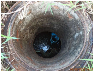
บ่อฟักน้ำหลังผ่านระบบบำบัดน้ำเสียสำเร็จรูปของอาคารที่ทำการดับเพลิงและหน่วยกู้ภัยทางด้านขวามือ
