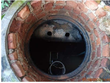
บ่อฟักน้ำหลังผ่านระบบบำบัดน้ำเสียสำเร็จรูปของอาคารผู้โดยสารขาเข้า
