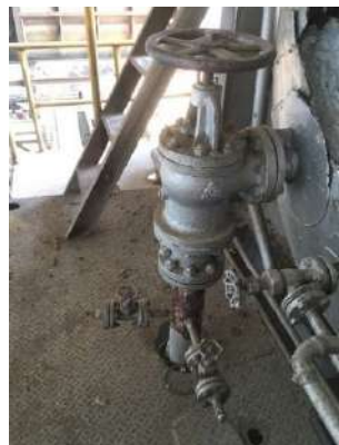
Check Valve หม้อไอน้ำ 40 ตัน/ชั่วโมง
