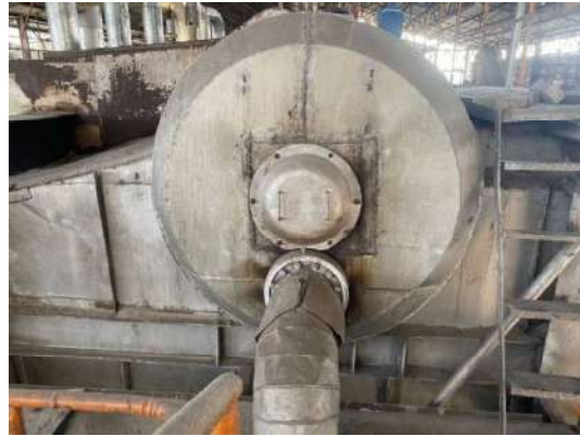
ฉนวนกันความร้อนหม้อไอน้ำ 60 ตัน/ชั่วโมง (3)
