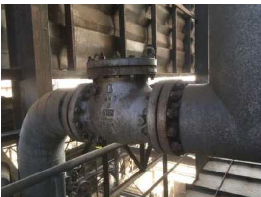
Check Valve หม้อไอน้ำ 200 ตัน/ชั่วโมง (A)
