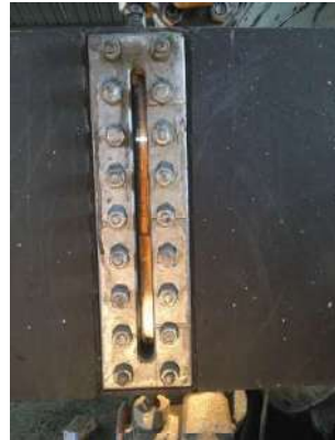
มาตรวัดระดับน้ำ หม้อไอน้ำ 80 ตัน/ชั่วโมง
