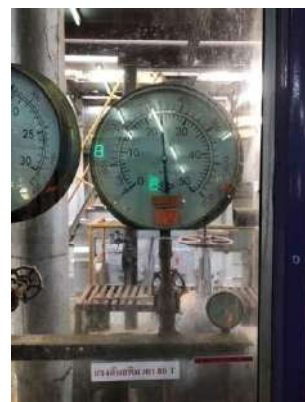
มาตรวัดความดันไอน้ำ หม้อไอน้ำ 80 ตัน/ชั่วโมง
