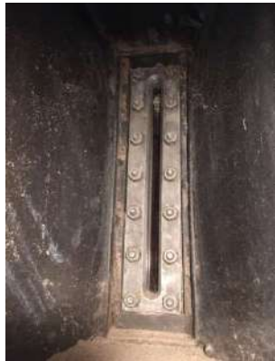
มาตรวัดระดับน้ำ หม้อไอน้ำ 40 ตัน/ชั่วโมง
