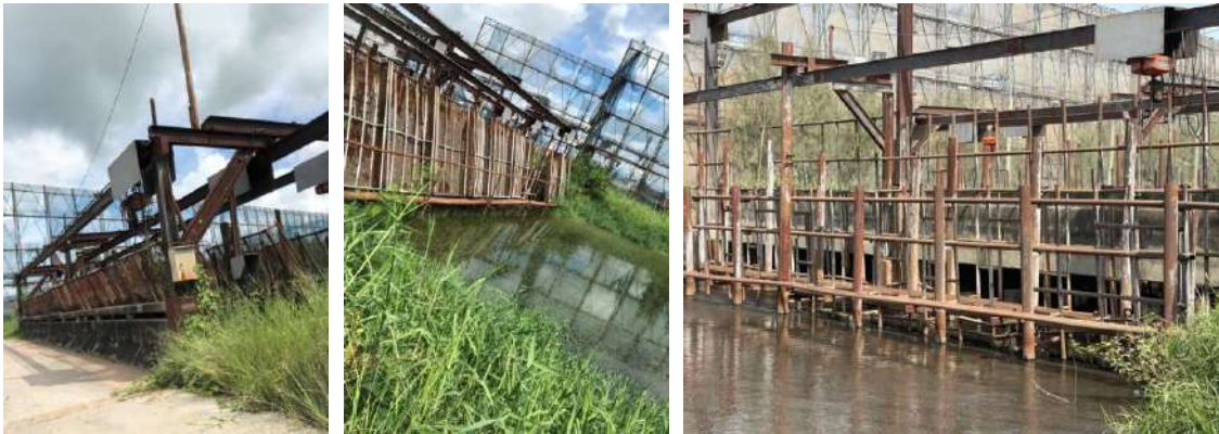
รูปที่ 3-23 ตะแกรงดักเศษกากอ้อยก่อนเข้าสู่ระบบบำบัดน้ำเสีย
