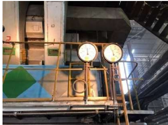
มาตรวัดความดันไอน้ำ หม้อไอน้ำ 200 ตัน/ชั่วโมง (A)
