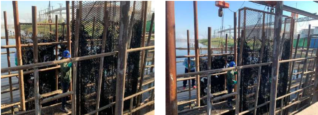
รูปที่ 3-24 เจ้าหน้าที่ทำความสะอาดตะแกรงดักเศษกากอ้อยและขยะ
