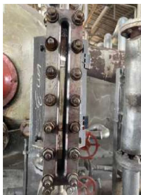
มาตรวัดระดับน้ำ หม้อไอน้ำ 60 ตัน/ชั่วโมง (3)
