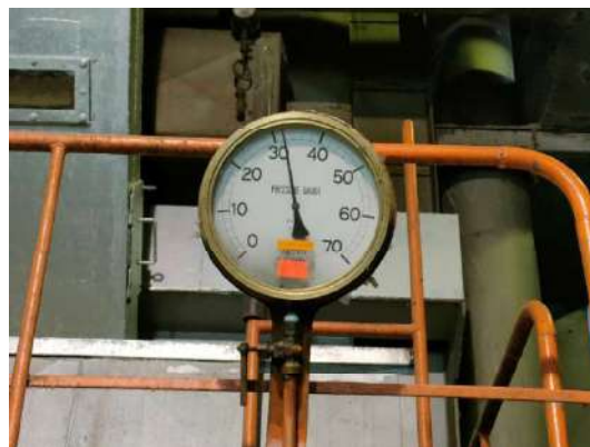
มาตรวัดความดันไอน้ำ หม้อไอน้ำ 200 ตัน/ชั่วโมง (B)
