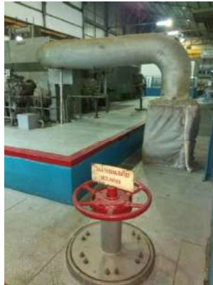
ฉนวนหุ้มกันความร้อนเทอร์ไบน์ Gen 3
