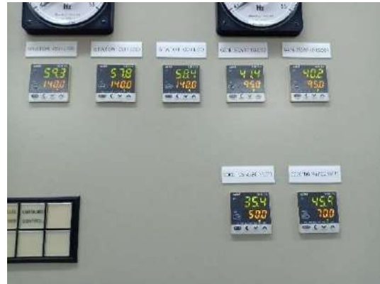
อุปกรณ์วัดอุณหภูมิขดลวดของเครื่องกำเนิดไฟฟ้า Gen 4
