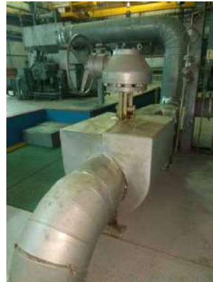
ฉนวนหุ้มกันความร้อนเทอร์ไบน์ Gen 4
