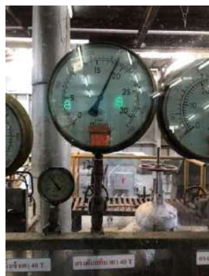
มาตรวัดความดันไอน้ำ หม้อไอน้ำ 40 ตัน/ชั่วโมง
