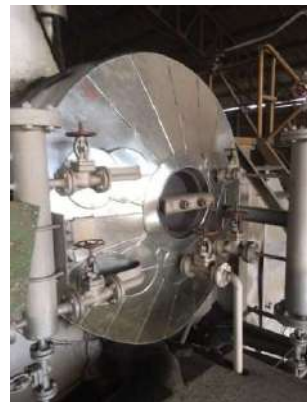
ฉนวนกันความร้อนของหม้อไอน้ำ 80 ตัน/ชั่วโมง
