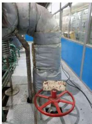
Bypass valve Turbine GEN.1
