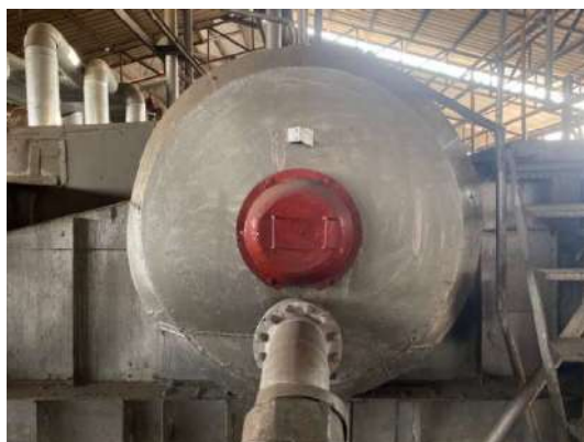
ฉนวนกันความร้อนของหม้อไอน้ำ 60 ตัน/ชั่วโมง (1)
