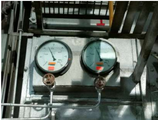
มาตรวัดความดันไอน้ำ หม้อไอน้ำ 60 ตัน/ชั่วโมง (3)
