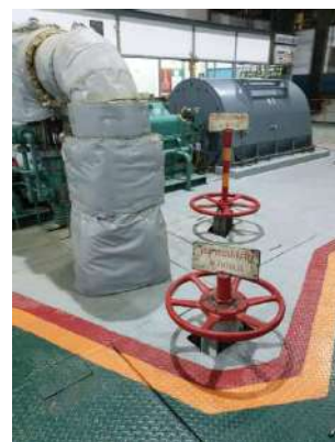
ฉนวนหุ้มกันความร้อนเทอร์ไบน์ Gen 2
