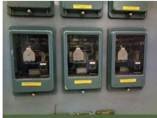
อุปกรณ์ป้องกันการรั่วไหลของแรงดันไฟฟ้า Gen 2
