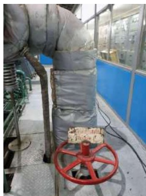
ฉนวนหุ้มกันความร้อนเทอร์ไบน์ Gen 1
