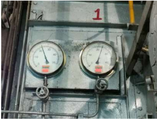
มาตรวัดความดันไอน้ำ หม้อไอน้ำ 60 ตัน/ชั่วโมง (1)
