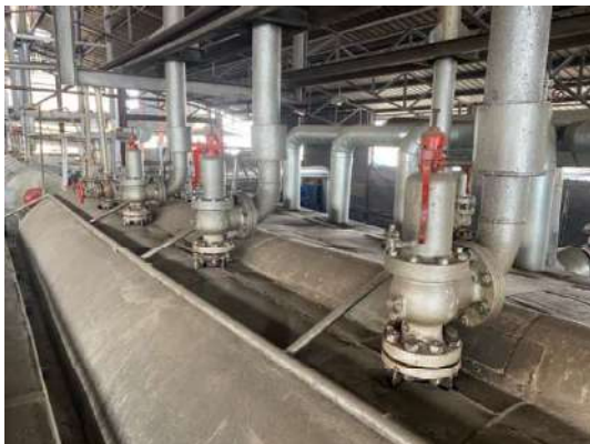
Safety Valve หม้อไอน้ำ 60 ตัน/ชั่วโมง(2)
