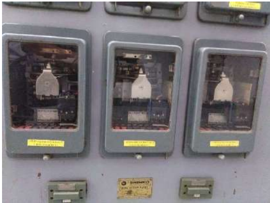
อุปกรณ์ป้องกันการรั่วไหลของแรงดันไฟฟ้า Gen 1
