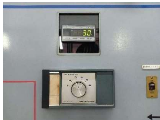
อุปกรณ์วัดอุณหภูมิขดลวดของเครื่องกำเนิดไฟฟ้า Gen 2
