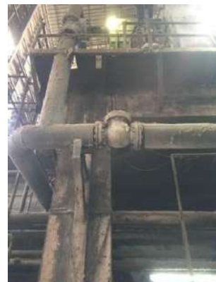
Check Valve หม้อไอน้ำ 80 ตัน/ชั่วโมง
