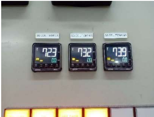
อุปกรณ์วัดอุณหภูมิขดลวดของเครื่องกำเนิดไฟฟ้า Gen 3
