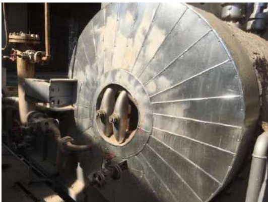
ฉนวนกันความร้อนของหม้อไอน้ำ 40 ตัน/ชั่วโมง
