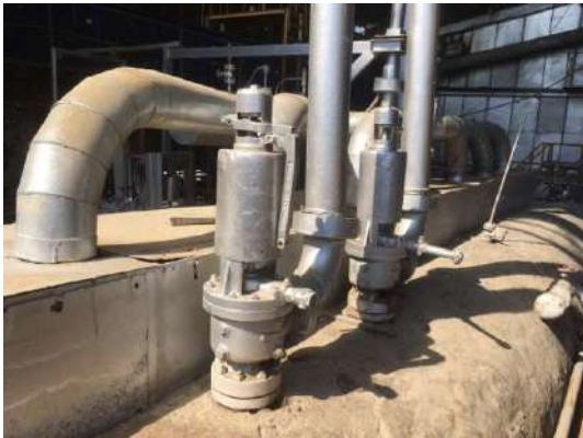
Safety Valve หม้อไอน้ำ 40 ตัน/ชั่วโมง
