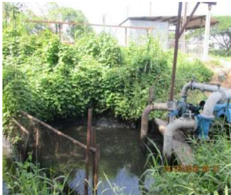
รูปที่ 3-26 บ่อแยกน้ำมัน (Oil Separator)
