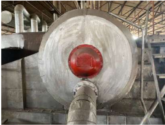
ฉนวนกันความร้อนหม้อไอน้ำ 60 ตัน/ชั่วโมง (2)
