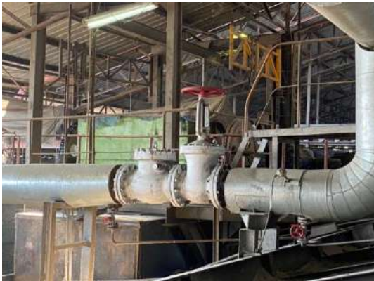
Check Valve หม้อไอน้ำ 60 ตัน/ชั่วโมง (1)
