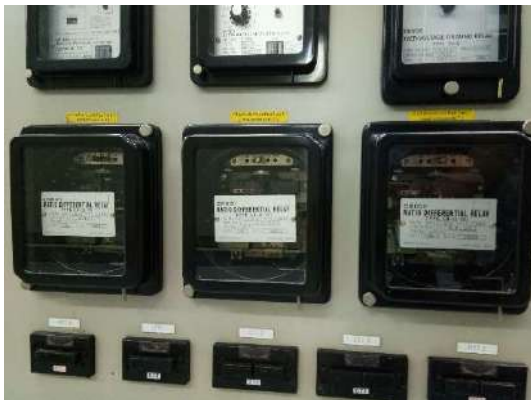
อุปกรณ์ป้องกันการรั่วไหลของแรงดันไฟฟ้า Gen 3
