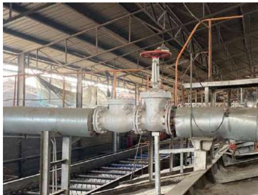
Check Valve หม้อไอน้ำ 60 ตัน/ชั่วโมง (3)
