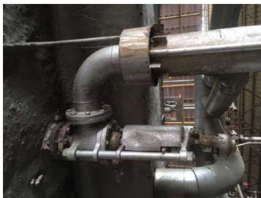
Safety Valve หม้อไอน้ำ 80 ตัน/ชั่วโมง
