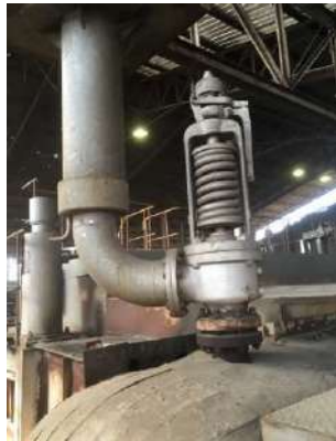
Safety Valve หม้อไอน้ำ 200 ตัน/ชั่วโมง (A)
