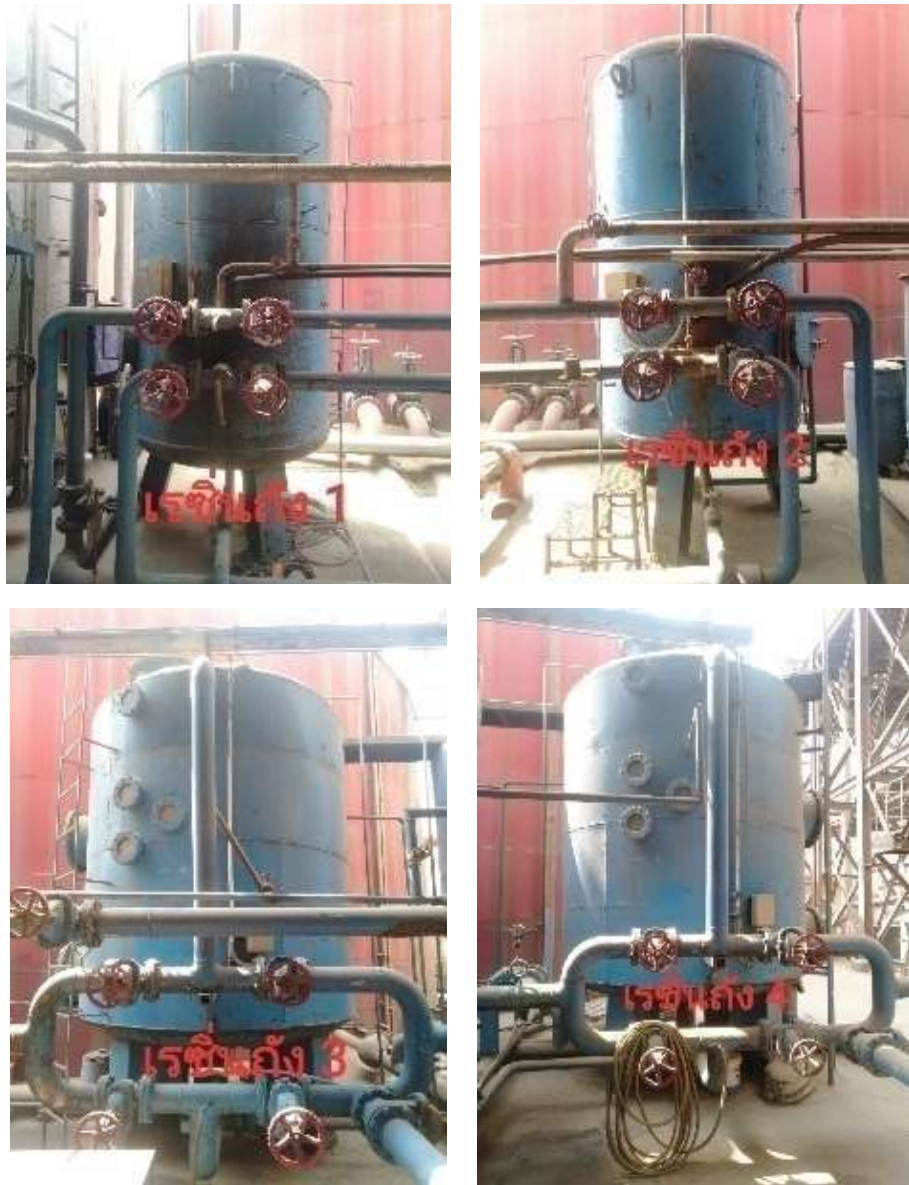
รูปที่ 2-15 ระบบผลิตน้ำอ่อน (Soft Water)
