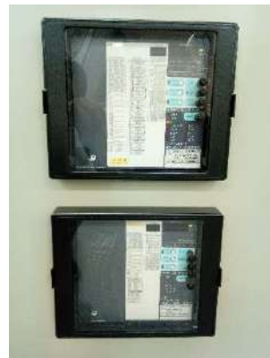
อุปกรณ์ป้องกันการรั่วไหลของแรงดันไฟฟ้า Gen 4
