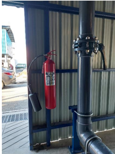
ภาพที่ 2-58 ถังดับเพลิงแบบมือถือชนิดสารเคมีแห้ง บริเวณอาคารติดตั้งระบบกรองน้ำแบบอัลตราฟิลเตรชัน (Ultrafiltration : UF)
