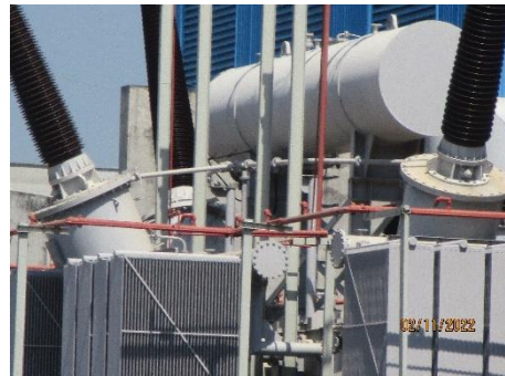
ภาพที่ 2-55 ระบบท่อฝอยน้ำดับเพลิง บริเวณหม้อแปลงแรงดันไฟฟ้า
