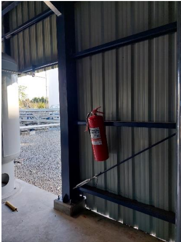
ภาพที่ 2-58 ถังดับเพลิงแบบมือถือชนิดสารเคมีแห้ง บริเวณอาคารติดตั้งระบบกรองน้ำแบบอัลตราฟิลเตรชัน (Ultrafiltration : UF)
