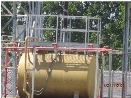
ภาพที่ 2-56 ระบบท่อฝอยน้ำดับเพลิง บริเวณพื้นที่ปฏิบัติงานที่อาจเกิดเพลิงไหม้
