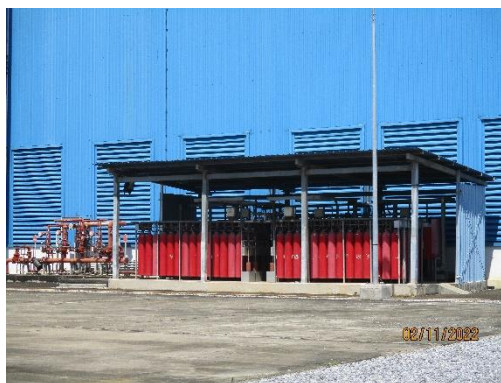
ภาพที่ 2-57 ระบบป้องกันเพลิงไหม้โดยใช้คาร์บอนไดออกไซด์บริเวณเครื่องกังหันก๊าซ
