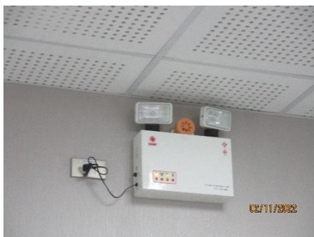
ภาพที่ 2-48 ระบบไฟฟ้าสำรองในอาคารผลิตและอาคารสำนักงาน
