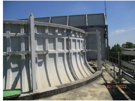
ภาพที่ 2-12 การติดตั้งค้ำยันปล่องพัดลม (Fan stack Stiffness)
