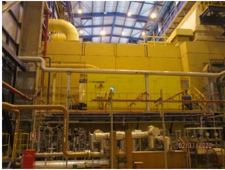
ภาพที่ 2-9 การติดตั้งผนังป้องกันและดูดซับเสียงเครื่องจักรที่มีเสียงดัง (Acoustic Wall)
