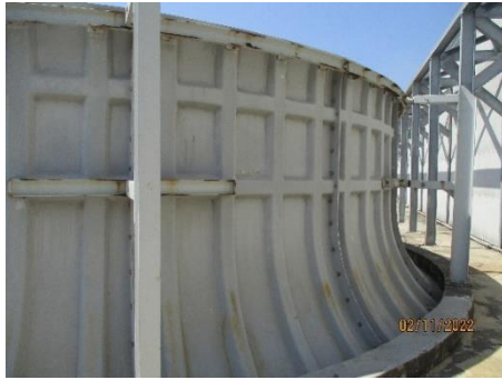
ภาพที่ 2-12 การติดตั้งค้ำยันปล่องพัดลม (Fan stack Stiffness)
