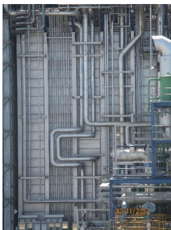
ภาพที่ 2-34 การติดตั้งฉนวนกันความร้อน (Insulation)
