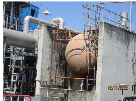
ภาพที่ 2-56 ระบบท่อฝอยน้ำดับเพลิง บริเวณพื้นที่ปฏิบัติงานที่อาจเกิดเพลิงไหม้
