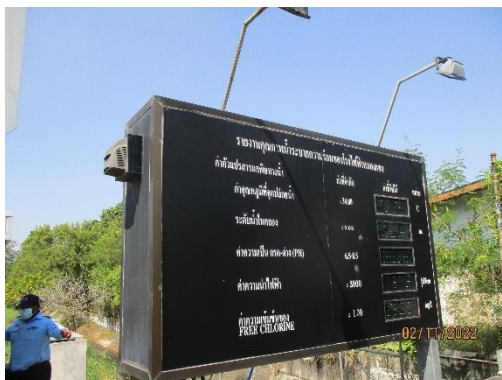
ภาพที่ 2-18 หน้าจอแสดงผลการติดตามตรวจสอบคุณภาพน้ำทั้งแบบต่อเนื่องของโรงไฟฟ้า
