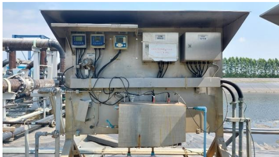
ภาพที่ 2-21 ระบบตรวจวัดอุณหภูมิของน้ำทิ้ง ที่ระบายจากหอหล่อเย็น
