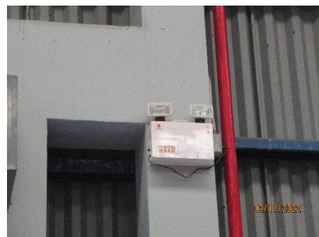
ภาพที่ 2-48 ระบบไฟฟ้าสำรองในอาคารผลิตและอาคารสำนักงาน
