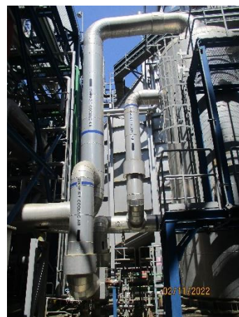
ภาพที่ 2-34 การติดตั้งฉนวนกันความร้อน (Insulation)
