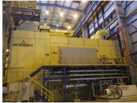
ภาพที่ 2-9 การติดตั้งผนังป้องกันและดูดซับเสียงเครื่องจักรที่มีเสียงดัง (Acoustic Wall)
