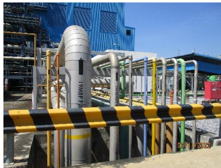
ภาพที่ 2-46 การทาสี และเครื่องหมายตัวอักษรทิศทางการไหลของระบบท่อ
