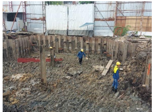
รูปที่ 7 Sheet Pile
