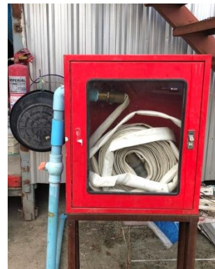
รูปที่ 2-69 หัวฉีดน้ำดับเพลิงและถังดับเพลิงมือถือแบบแห้ง บริเวณบ้านพักคนงาน
