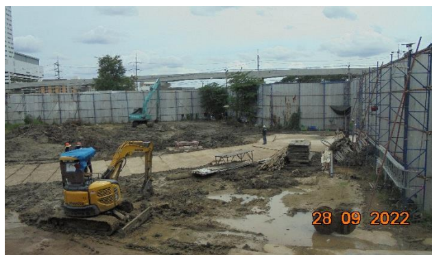
รูปที่ 2-2 รั้ว Metal Sheet สูง 6 เมตร และประตูทางเข้า-ออก พื้นที่ก่อสร้าง
