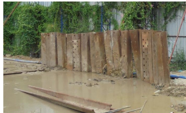
รูปที่ 2-31 การป้องกันดินพัง (Sheet Pile) ในช่วงงานฐานราก
