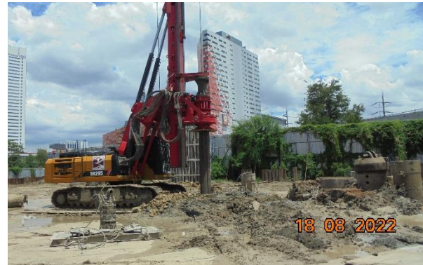
รูปที่ 2-30 การใช้เสาเข็มแบบเจาะในช่วงงานฐานราก
