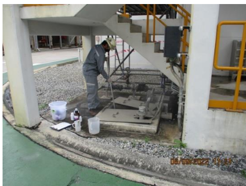
บ่อพักน้ำเสีย (Inspection Pit) (V100-2-U) ขนาด 1 ลบ.ม. (SW3)
