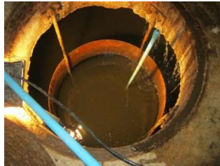
ภาพที่ 3-B ปอสูบตะกอนกลับ
