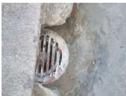
ภาพที่ 6-H สภาพท่อระบายน้ำรอบห้องพักขยะ ซึ่งน่าที่เกิตขึ้นมีการระบายลงสู่ระบบบำบัดน้ำเสียของโรงพยาบาล
