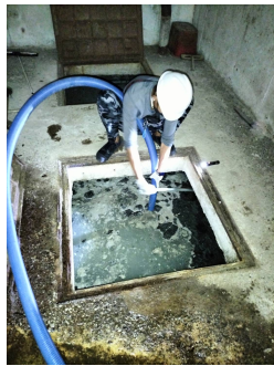
ภาพที่ 3-D ปอดักไขมัน มีการดูแลประจําวัน โดยมีการสูบตะกอนส่วนเกินไปกำจัด ทุกวันที่ 10,20,30 ของเดือน
