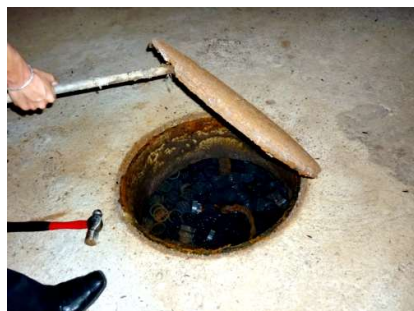
ภาพที่ 3-E การตรวจสอบฝาปิดบ่อน้ำเสียประจําเดือน
