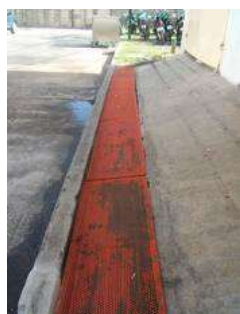
ภาพที่ 6-H สภาพท่อระบายน้ำรอบห้องพักขยะ ซึ่งน่าที่เกิตขึ้นมีการระบายลงสู่ระบบบำบัดน้ำเสียของโรงพยาบาล
