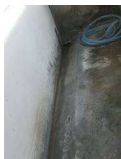
ภาพที่ 6-H สภาพท่อระบายน้ำรอบห้องพักขยะ ซึ่งน่าที่เกิตขึ้นมีการระบายลงสู่ระบบบำบัดน้ำเสียของโรงพยาบาล
