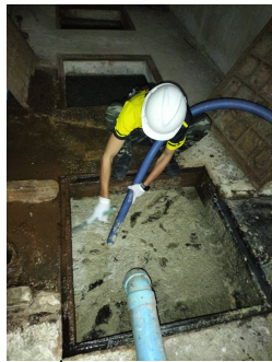
ภาพที่ 3-D ปอดักไขมัน มีการดูแลประจําวัน โดยมีการสูบตะกอนส่วนเกินไปกำจัด ทุกวันที่ 10,20,30 ของเดือน
