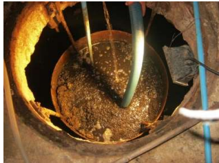
ภาพที่ 3-B ปอสูบตะกอนกลับ
