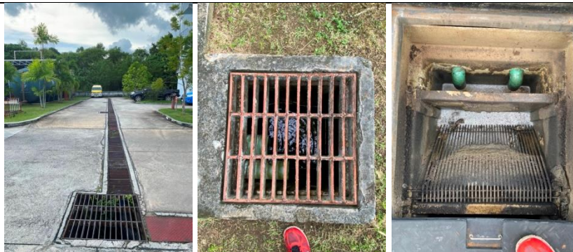
(ภาพที่ 20) การดูแลท่อระบายน้ำ ตะแกรง และบ่อหน่วงดักตะกอน
