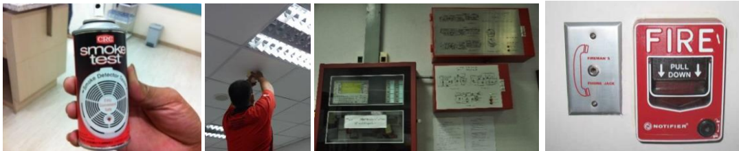
รูปที่ 25 การตรวจสอบสภาพความพร้อมใช้ของระบบสัญญาณแจ้งเหตุเพลิงไหม้
