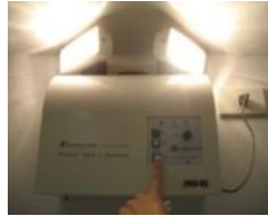
รูปที่ 24 การตรวจสอบสภาพความพร้อมใช้ของระบบไฟฉุกเฉินในโรงพยาบาล
