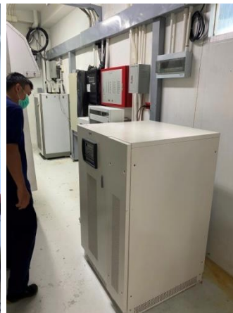
(ภาพที่ 17) เครื่อง Generator และเครื่องสำรองไฟ (UPS)
