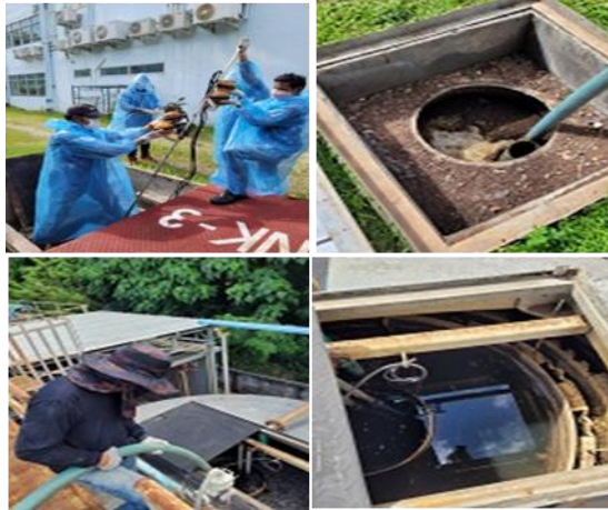
(ภาพที่ 18) การตรวจสอบและกำจัดตะกอนส่วนเกินจากระบบบำบัดน้ำเสีย
