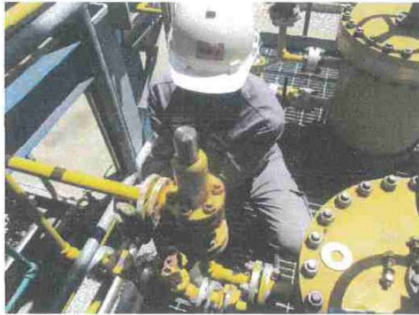
รูปที่ 1 การทดสอบกลดอุปกรณ์นิรภัย
