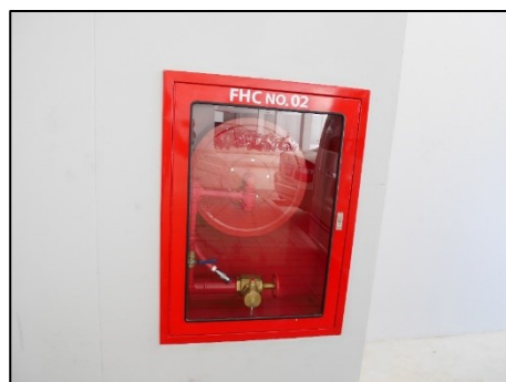
ตู้เก็บสายฉีดน้ำดับเพลิงและหัวจ่ายน้ำ
