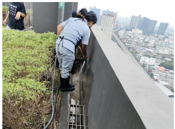
รูปที่ 9 การตรวจสอบที่ระบายน้ำไม่ให้มีขยะไปอุดตัน การแตกหักและบ่อดักตะกอน
