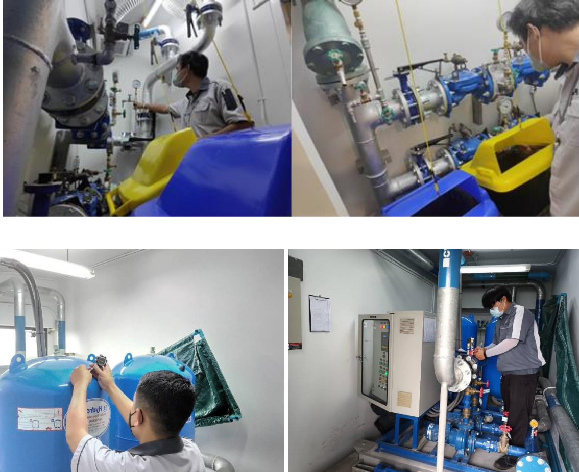
รูปที่ 4 ตรวจสอบการรั่วซึม หรือแตกของท่อจ่ายน้ำประปา
