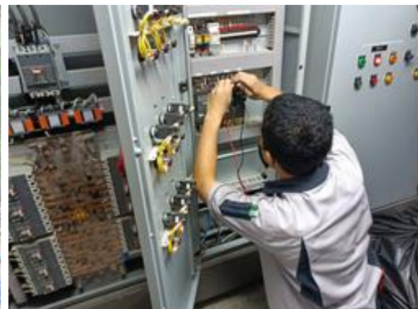
ตรวจเช็คตู้ควบคุมระบบบำบัดน้ำเสีย
