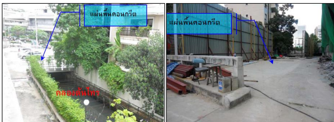
ภาพที่ 2.1-1 สภาพแผ่นพื้นคอนกรีตวางเรียงอยู่บนคลองตันไทร
