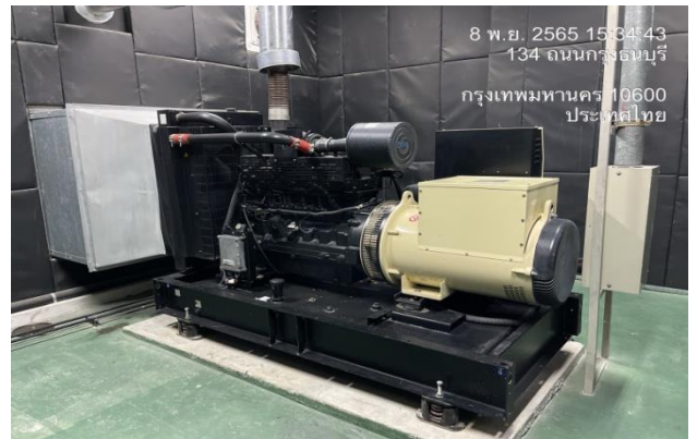
ภาพที่ 19 เครื่องกำเนิดไฟฟ้าสำรอง
