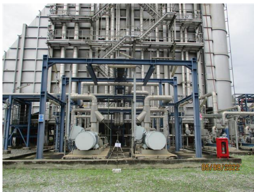
Boiler Feed Pump HRSG#12
