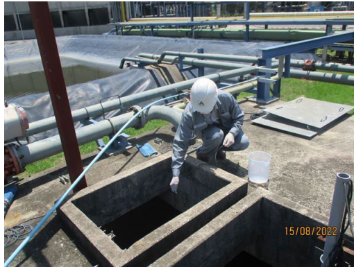
บ่อพักน้ำทิ้ง (Wastewater Holding Pond)
