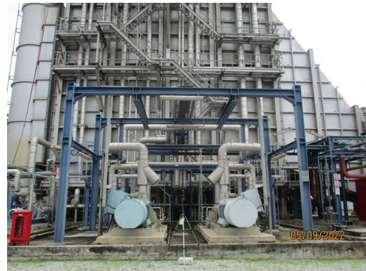
Boiler Feed Pump HRSG#11
