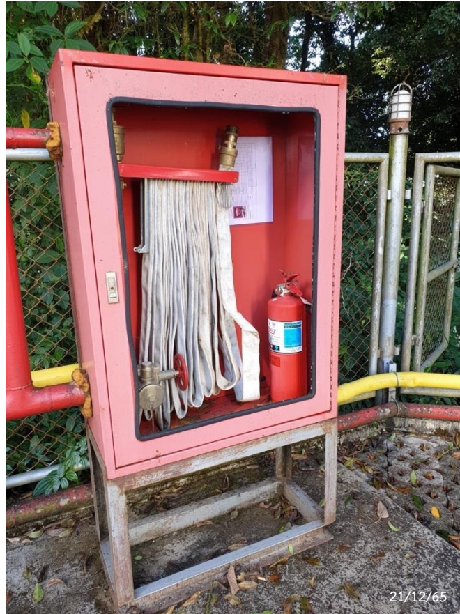
ภาพที่ 24 ตู้เก็บอุปกรณ์ดับเพลิง และอุปกรณ์ช่วยเหลืออื่นๆ
