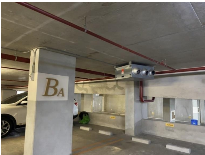
รูปที่ 11 พัดลมดูดอากาศในอาคารจอดรถ A,B
