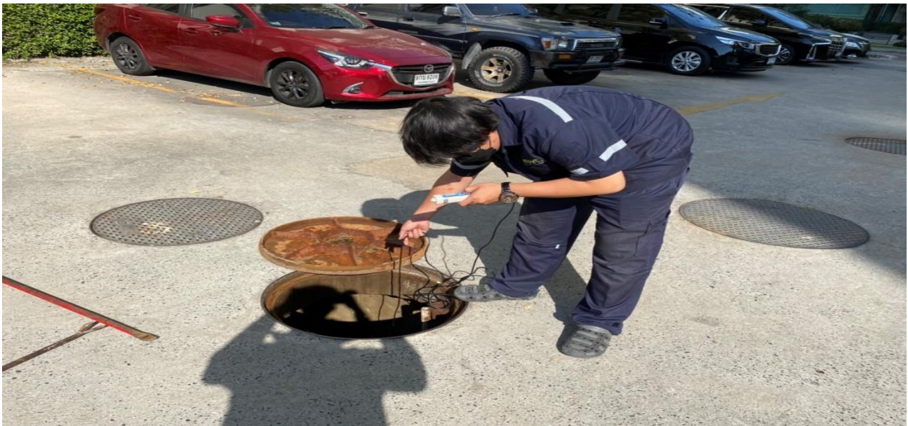
รูปที่ 14 ดำเนินการตรวจวัดค่า DO บ่อเติมอากาศระบบบำบัดน้ำเสีย Plant 1-4
