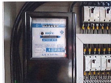
ภาพที่ 12 ระบบมิเตอร์ไฟฟ้าสำหรับระบบบำบัดน้ำ เสีย
