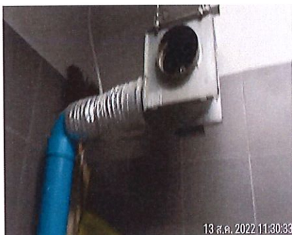
ภาพที่ 28 ท่อระบายอากาศจากห้องพักมูลฝอยขยะเปียก
