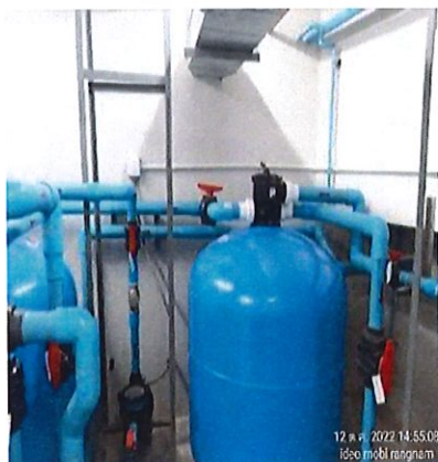
ภาพที่ 56 ระบบกรองสระว่ายน้ำ
