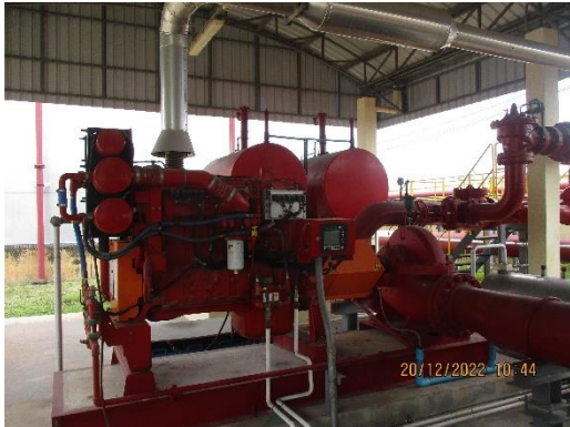
ภาพที่ 2-23 เครื่องสูบน้ำดับเพลิง
