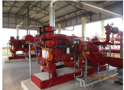
ภาพที่ 2-23 เครื่องสูบน้ำดับเพลิง
