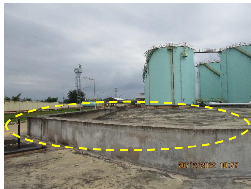
ภาพที่ 2-30 คันคอนกรีตล้อมรอบถังเก็บน้ำมัน
