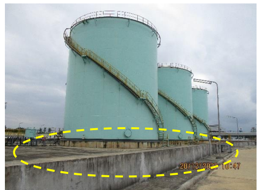
ภาพที่ 2-30 คันคอนกรีตล้อมรอบถังเก็บน้ำมัน
