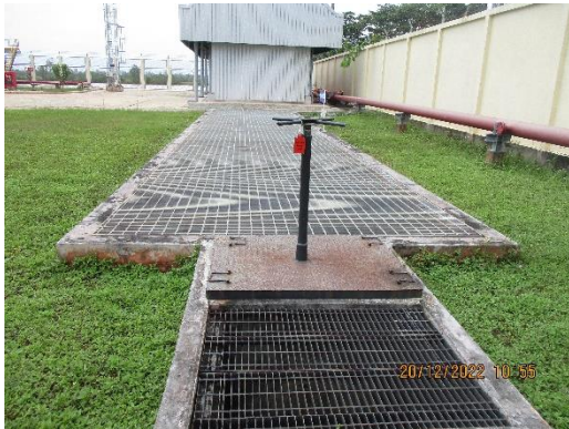
รางระบายน้ำปนเปื้อนน้ำมัน
