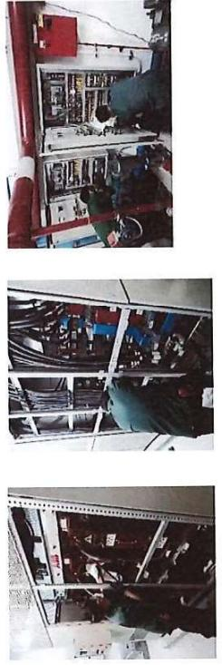
2)ติดตั้งระบบไฟฟ้าจุลเฉิน ขนาด 250 KVA จำนวน 1 ยูต และ Battery ขนาด 12 V ซึ่งสามารถสำรองไฟได้ไม่ต่ำกว่า 2 ชั่วโมง
