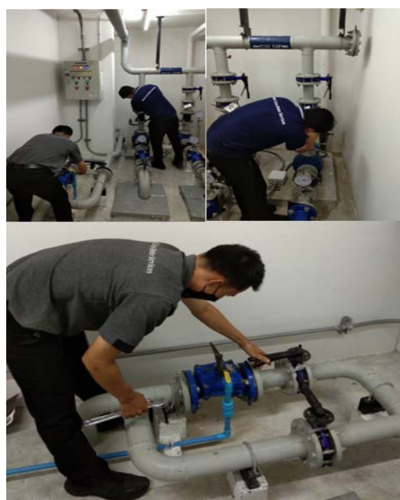
ภาคผนวกที่ 3.36 ตรวจสอบการรั่วซึมของท่อส่งน้ำประปา
