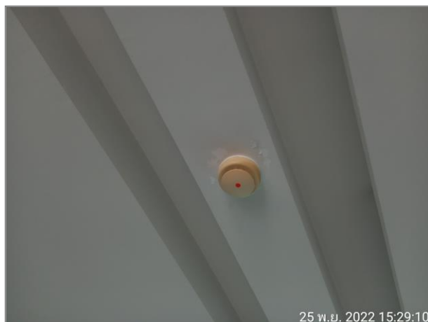
รูปที่ 2.27 เครื่องตรวจจับควัน
