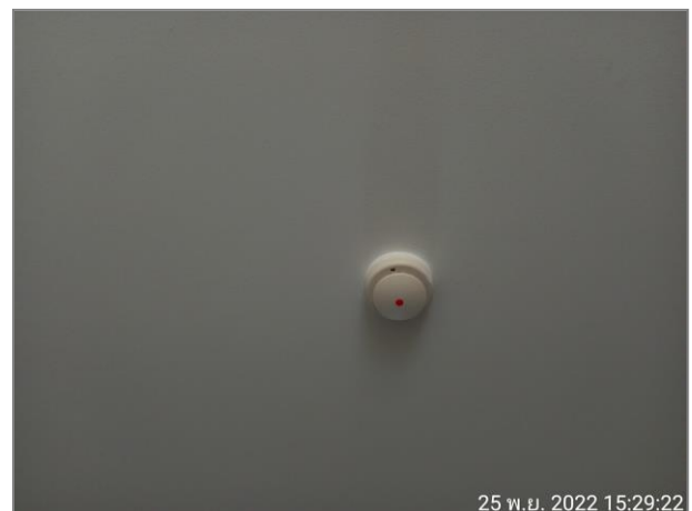
รูปที่ 2.27 เครื่องตรวจจับควัน
