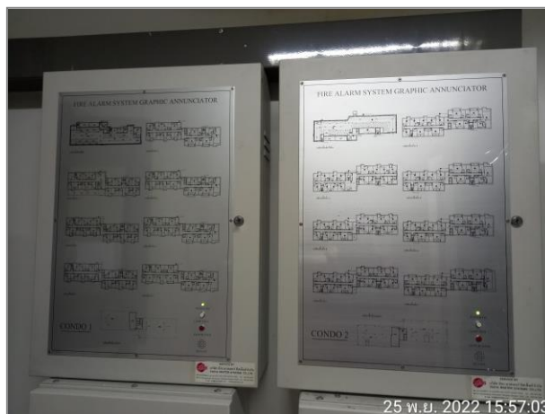
รูปที่ 2.26 แผงควบคุม FPC
