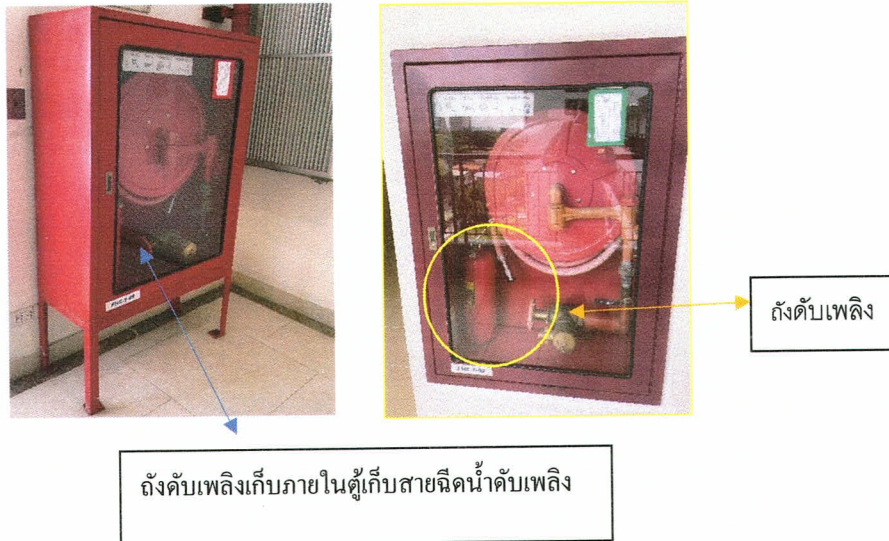
ภาพที่ 2 - 21 ตู้เก็บสายฉีดน้ำดับเพลิง พร้อมอุปกรณ์ (FHC)
