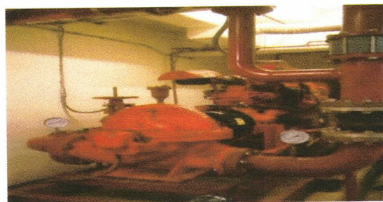
ภาพที่ 2 - 20 ระบบท่อยื่น และเครื่องสูบน้ำดับเพลิง
