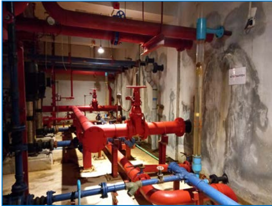
รูปที่ 2.31 ระบบ fire pump
