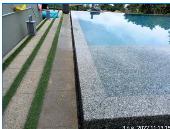
รูปที่ 2.41 รางระบายน้ำล้น และที่อาบน้ำล้างตัวบริเวณสระว่ายน้ำ
