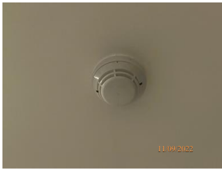
รูปที่ 2-59 เครื่องตรวจจับควัน (Smoke Detector)
