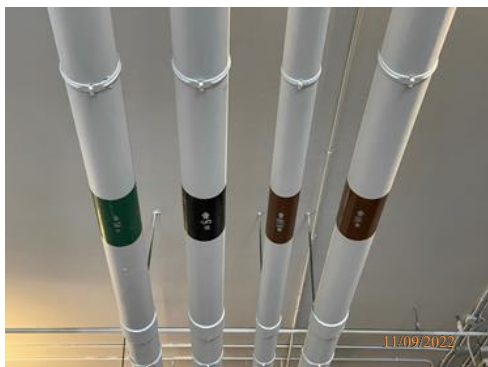
รูปที่ 2-36 ท่อรวบรวมน้ำเสียจากห้องพักรวมหลายห้อง
