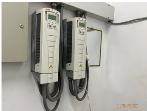
รูปที่ 2-48 อุปกรณ์ปรับความเร็วรอบมอเตอร์ VSD
