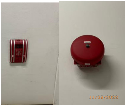
รูปที่ 3-65 อุปกรณ์ในระบบป้องกันและสัญญาณเตือน อัคคีภัย
