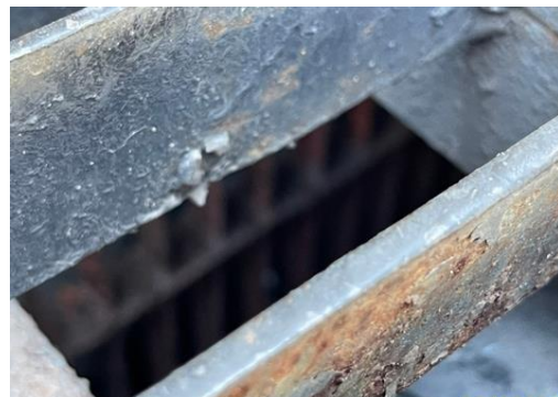
ท่อระบายน้ำพร้อมตะแกรงดักขยะก่อนระบายออกนอกโครงการ
