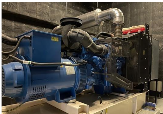
เครื่องกำเนิดไฟฟ้าสำรอง 350 KVA
