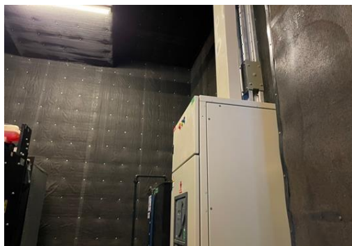
ผนังกันเสียงห้องเครื่องกำเนิดไฟฟ้าสำรอง
