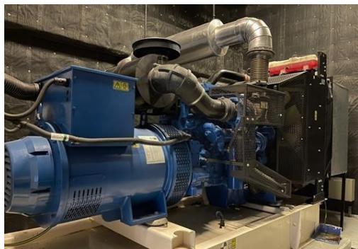
เครื่องกำเนิดไฟฟ้าสำรอง ขนาด 350 KVA จำนวน 1 ชุด
