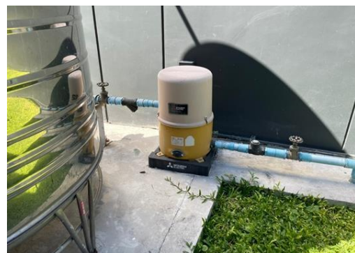
ถังเก็บน้ำสำเร็จรูปอาคารบริการ พร้อมเครื่องปั้มน้ำ
