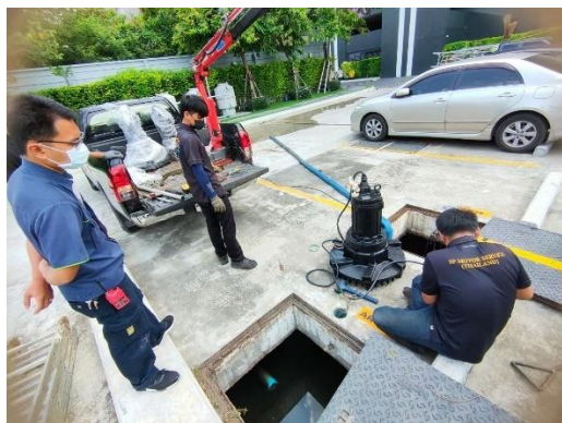
เจ้าหน้าที่ฝ่ายช่างดำเนินการตรวจสอบ และบำรุงรักษาระบบบำบัดน้ำเสีย
