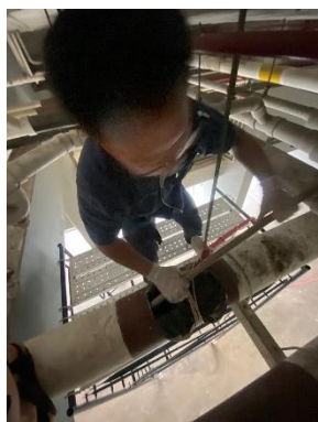
เจ้าหน้าที่ฝ่ายช่างดำเนินการแก้ไขท่อไขมัน (สูบลากลอกท่อระบายน้ำดำเนินการช่วงเดือน กรกฎาคม )
