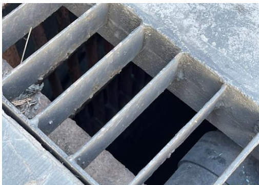
ท่อระบายน้ำพร้อมตะแกรงดักขยะก่อนระบายออกนอกโครงการ
