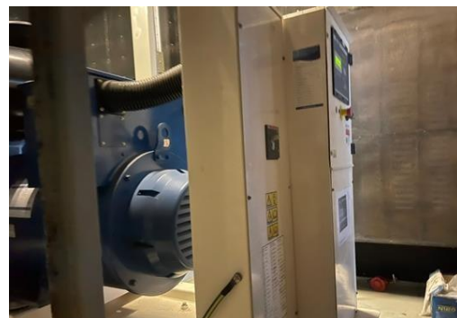
ผนังกันเสียงห้องเครื่องกำเนิดไฟฟ้าสำรอง
