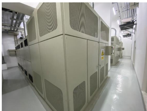
หม้อแปลงไฟฟ้า ชนิด DRY TYPE ขนาด 2,000 KVA จำนวน 3 ชุด
