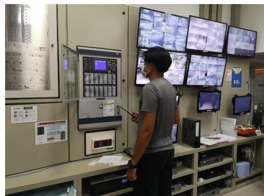
เจ้าหน้าที่ฝ่ายช่างดำเนินการตรวจสอบ และบำรุงรักษาอุปกรณ์ป้องกันและแจ้งเหตุเพลิงไหม้
