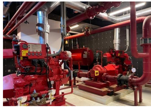
ถังเก็บน้ำดับเพลิง พร้อมเครื่องสูบน้ำ ดับเพลิง
