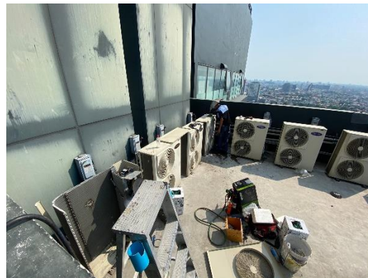
เจ้าหน้าที่ดำเนินการล้างเครื่องปรับอากาศพื้นที่ส่วนกลาง
