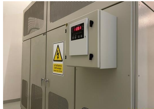
หม้อแปลงไฟฟ้า ชนิด DRY TYPE ขนาด 2000 KVA จำนวน 3 ชุด
