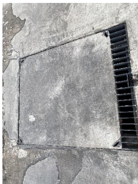
รางระบายน้ำ พร้อมฝาตะแกรงครอบ
