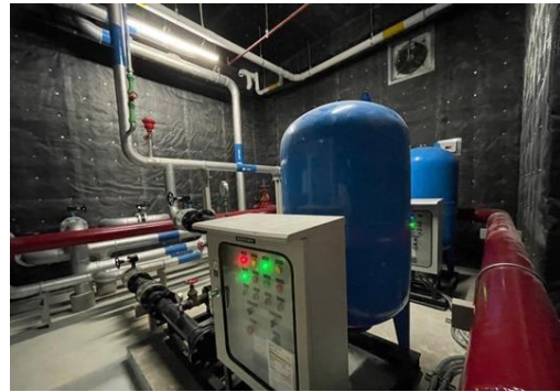
ถังเก็บน้ำชั้น 41 พร้อมเครื่องปั้มน้ำ
