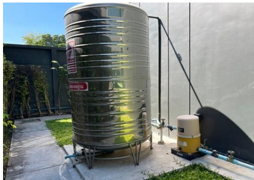
ถังเก็บน้ำ พร้อมเครื่องปั้มน้ำอาคารบริการ
