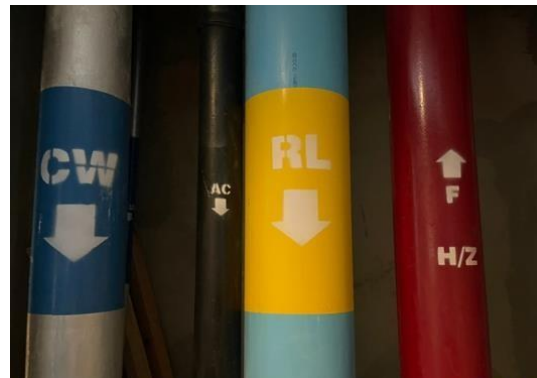
ท่อรวบรวมน้ำทิ้ง และน้ำฝน
