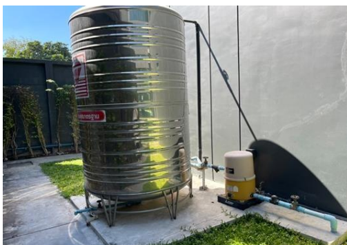
ถังเก็บน้ำสำเร็จรูปอาคารบริการ พร้อมเครื่องปั้มน้ำ
