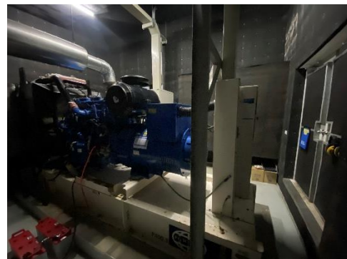
เครื่องกำเนิดไฟฟ้าสำรอง ขนาด 350 KVA จำนวน 1 ชุด
