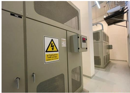
หม้อแปลงไฟฟ้า ชนิด DRY TYPE ขนาด 2000 KVA จำนวน 3 ชุด
