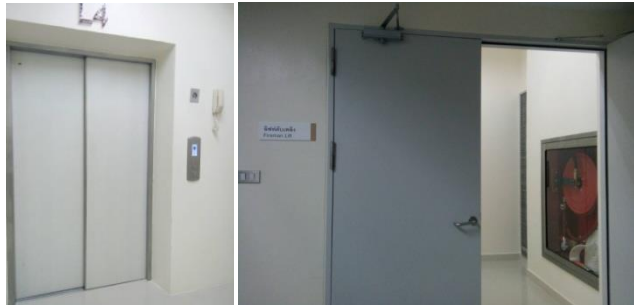
ภาพแสดง ลิฟต์ดับเพลิงและประตูหน้าลิฟต์ดับเพลิง
