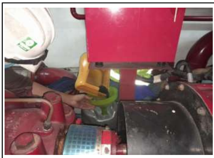
ทำการเปลี่ยนถ่ายและเติมน้ำมันเครื่องยนต์ Fire Pump
