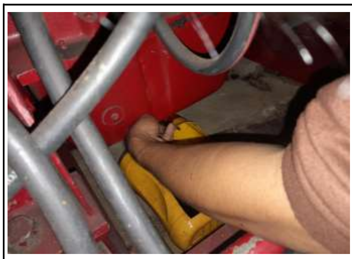
ทำการถ่ายน้ำมันเครื่องยนต์ Fire Pump เก่าออก
