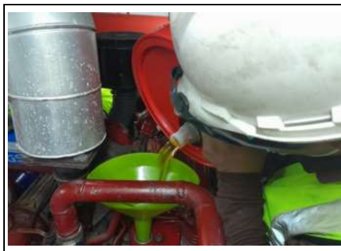
ทำการเปลี่ยนถ่ายและเติมน้ำมันเครื่องยนต์ Fire Pump
