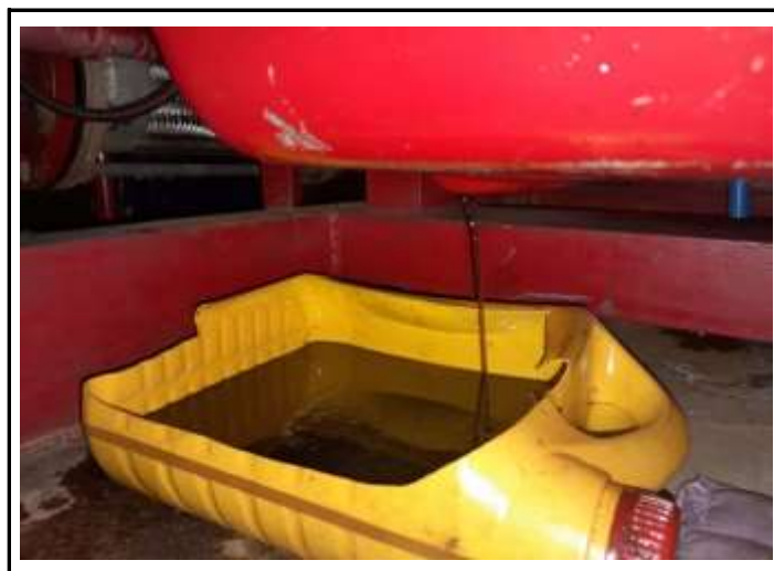
ทำการถ่ายน้ำมันเครื่องยนต์ Fire Pump เก่าออก
