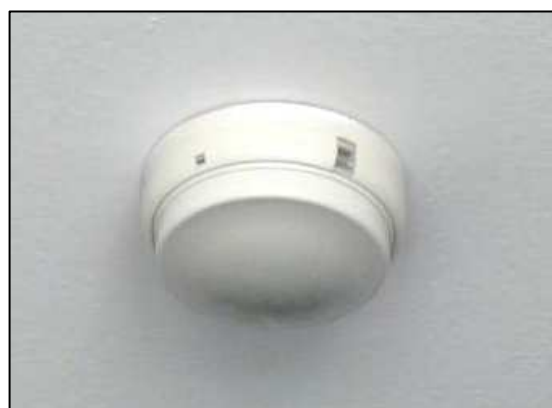
ภาพที่ 1-14 เครื่องตรวจจับความร้อน
