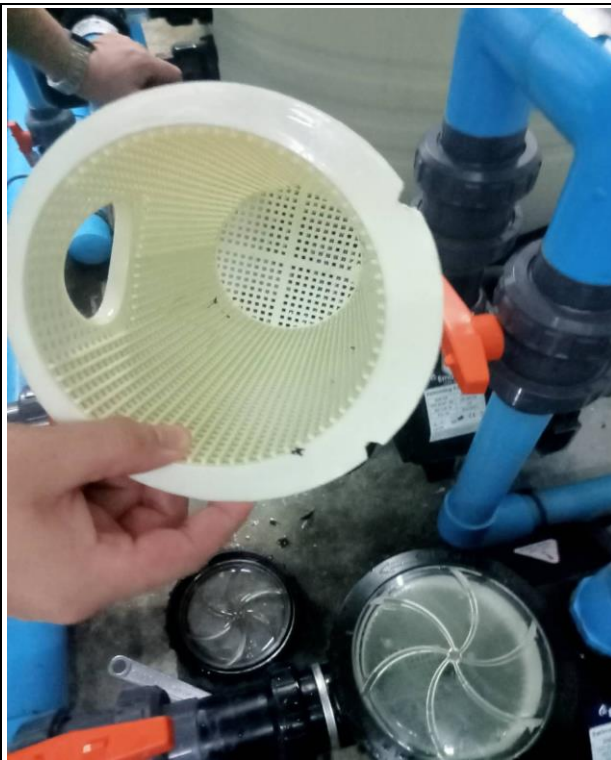
ภาคผนวกที่ 3.29 การทำความสะอาดระบบกรอง น้ำ
