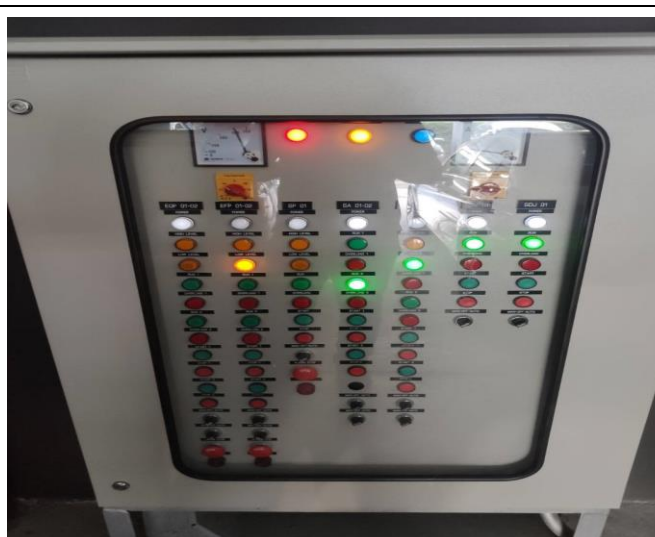
รูปที่ 2.4.2.2-3 ตู้ควบคุมระบบบำบัดน้ำเสีย
