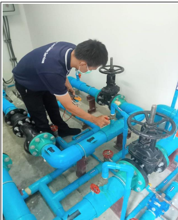
ภาคผนวกที่ 3.7 การตรวจสอบระบบส่งน้ำในอาคาร
