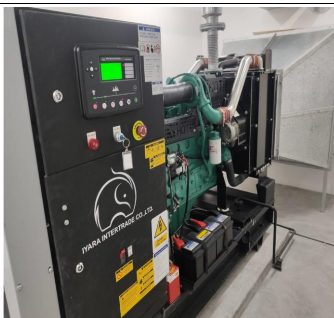
รูปที่ 2.4.5.2-1 เครื่องกำเนิดไฟฟ้าสำรอง
