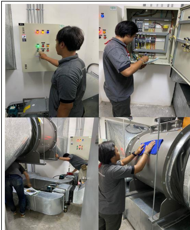
ภาคผนวกที่ 3.37 การตรวจสอบการทำงานพักมอด อากาศบันไดหนีไฟ
