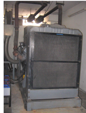
ภาพที่ 1-11 เครื่องกำเนิดไฟฟ้าสำรอง (Generator)
