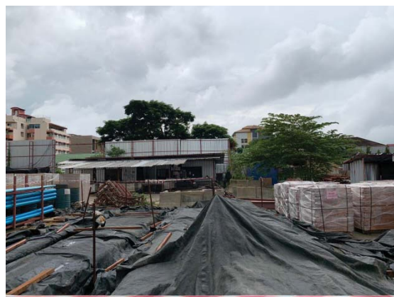
รูปที่ 6 การปิดคลุมกองวัสดุ อุปกรณ์การก่อสร้าง
