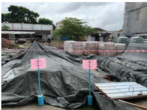
รูปที่ 6 การปิดคลุมกองวัสดุ อุปกรณ์การก่อสร้าง
